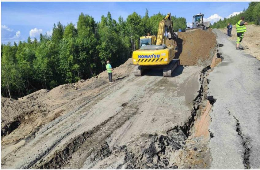
Провал грунта из-за образовавшегося пльвунна, июль 2023
